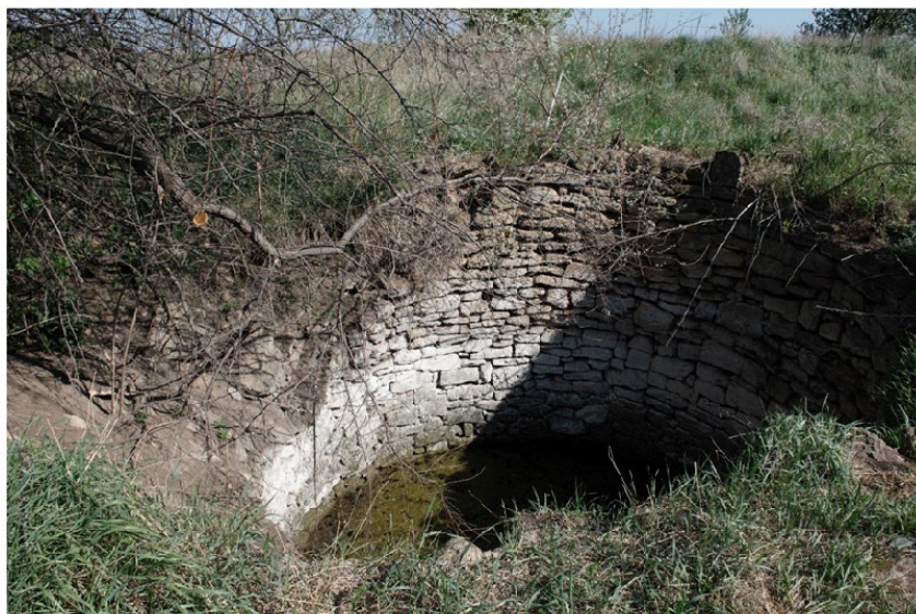
Рис. 3 Криниця питного водопостачання, 250 м на північ від каналу Дніпро-Кривий Ріг, яка дренує воду в лесовидних суглинках (залишкову воду техногенного підтоплення), географічні координати: N 47° 33' 55.77", E 33° 50' 40.28" (фото з експедиції 1–5 травня 2025 р., 22 липня 2025 р. ця криниця висохла, що буде враховано на етапі рішення зворотних фільтраційних задач).
