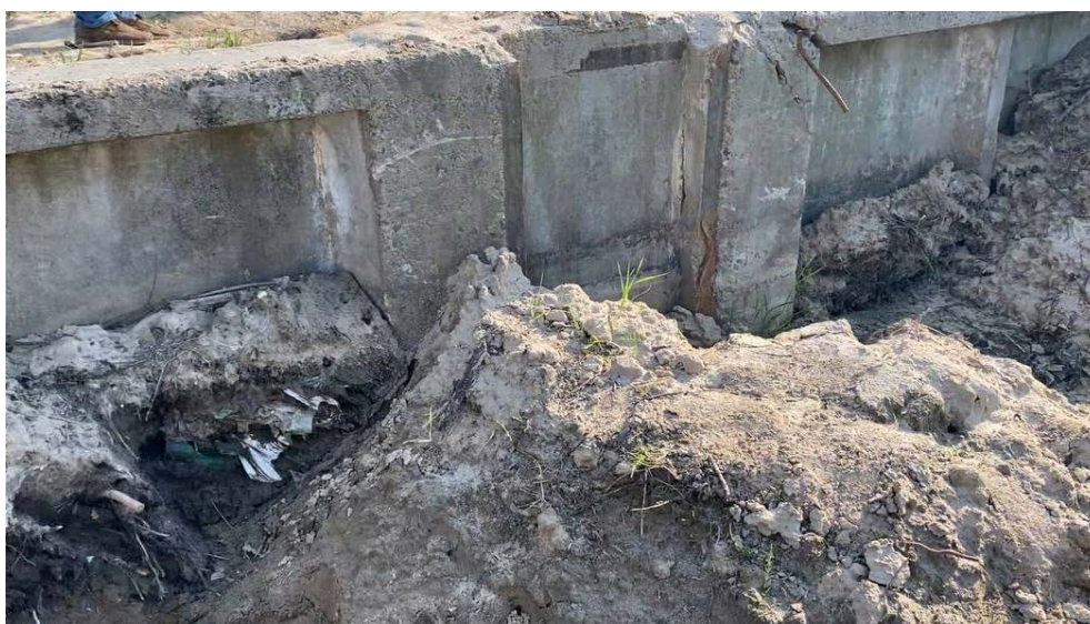
Рис. 5. Бетонні конструкції у південному борту штучної водойми, що дренує забруднений потік (травень 2023).
