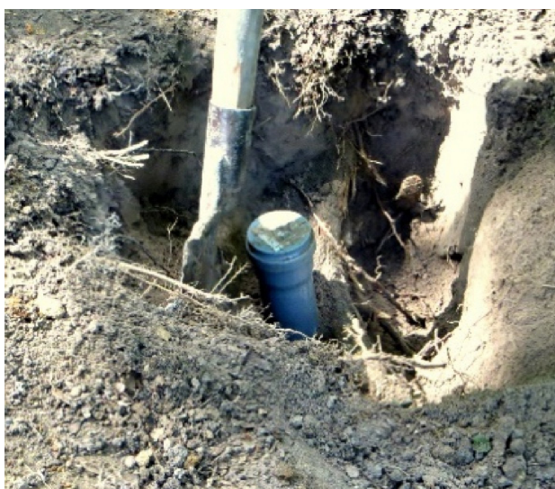
Рис. 4. Буріння спостережних свердловин і заміри рівнів ґрунтових вод і нафтопродуктів.
